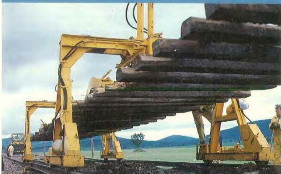
2 Una vez izado el tramo se traslada a depositarlo sobre los diploys.
