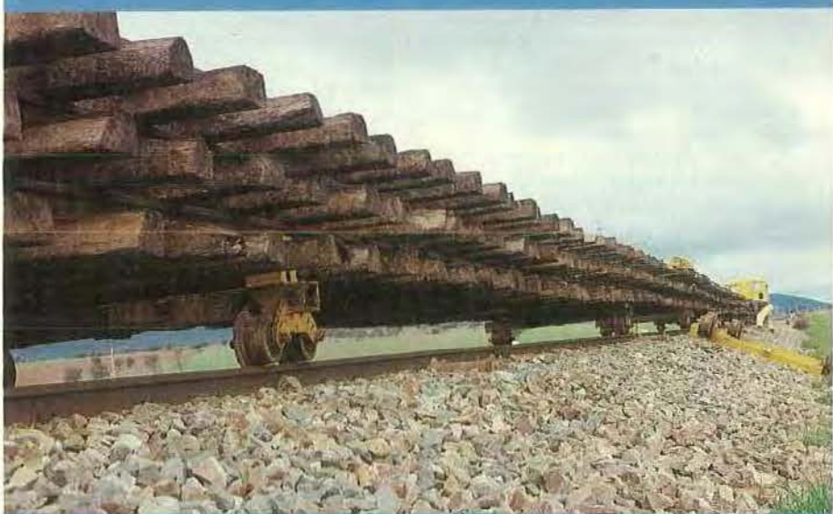
3 Los tramos, de 12 m de longitud, camino de la estación de Urda.
